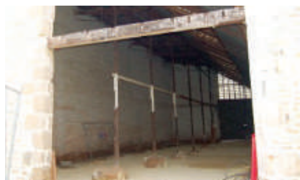
Intérieur de la future médiathèque et salle d'exposition.
