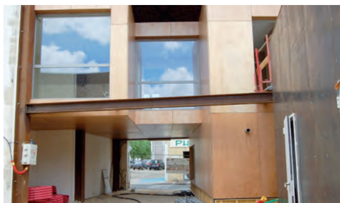
Vue extérieure - Maison de services
