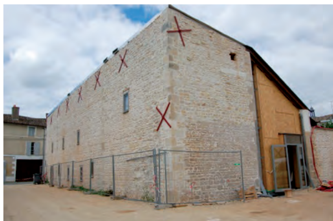
Vue extérieure de la médiathèque
